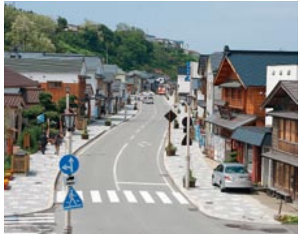
電線の地中化により空もすっきり
