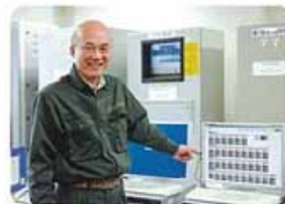
発電や蓄電の状況をコンピュータでコントロールしています。
